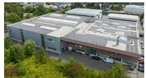
APL Apparatebau Dormagen . Deutschland APL Apparatebau Dormagen . Germany
